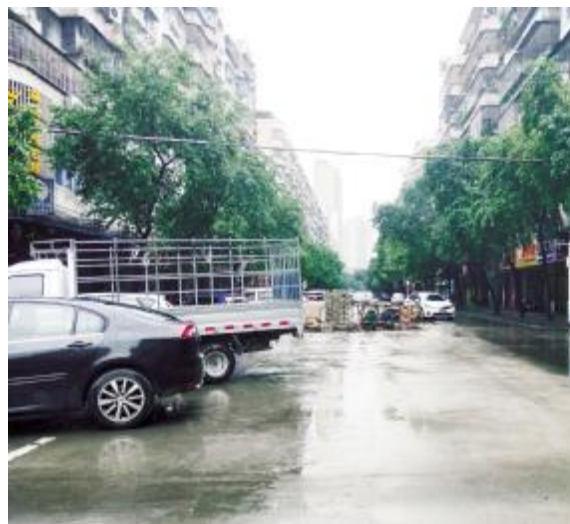
→清城区上、下廓街工程砂石未采用防尘网覆盖且堆放在围挡外。
